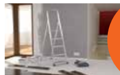
Rénovations de logements
